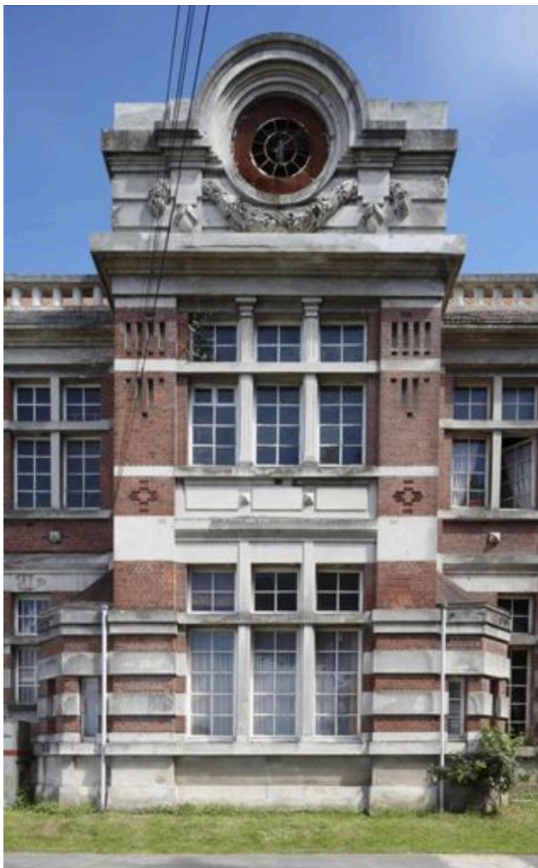
Vue générale de la travée centrale de l'élévation antérieure des bureaux.
