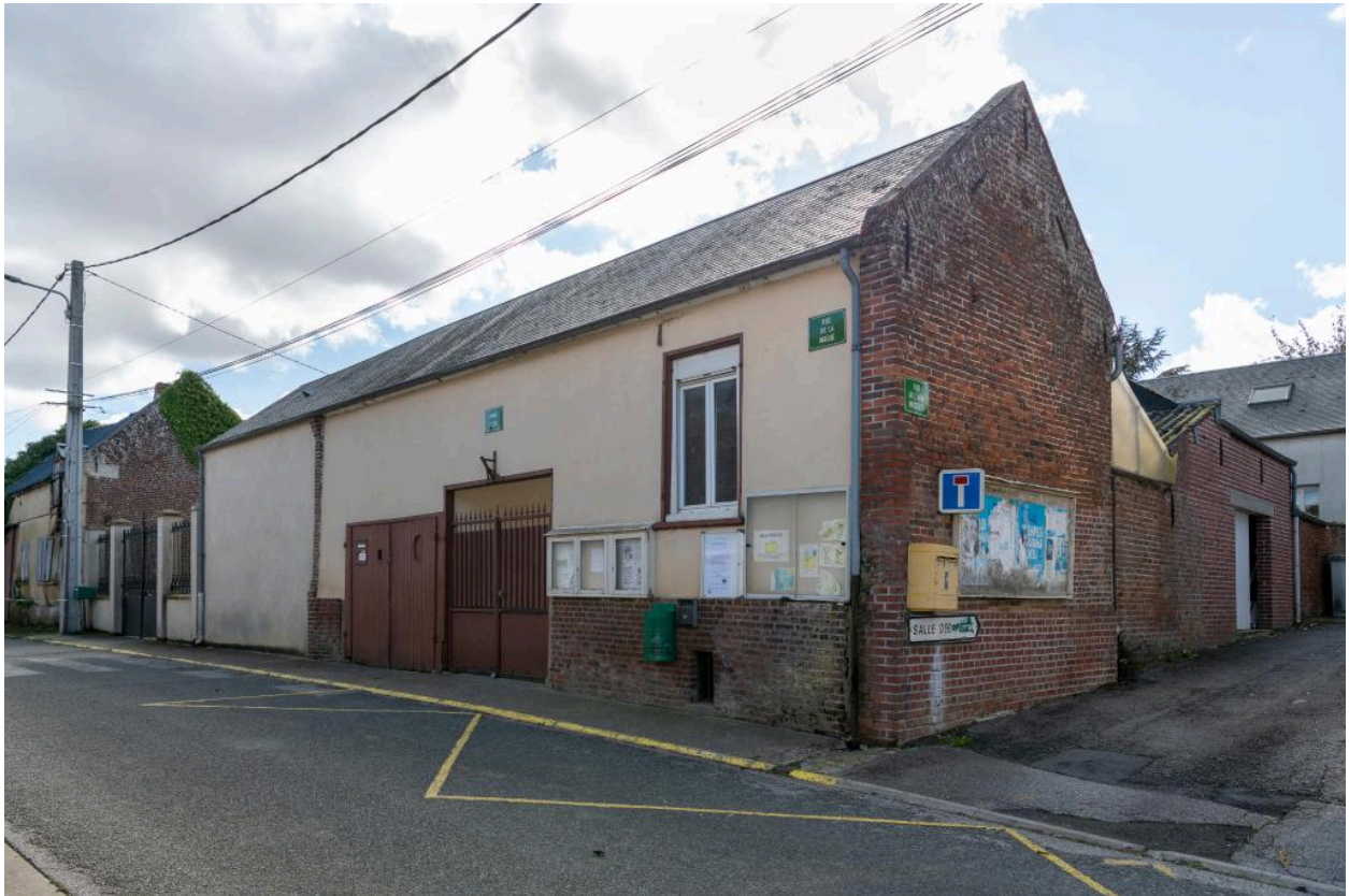
Ancienne mairie-école (aujourd'hui école), vue depuis le nord-ouest.
