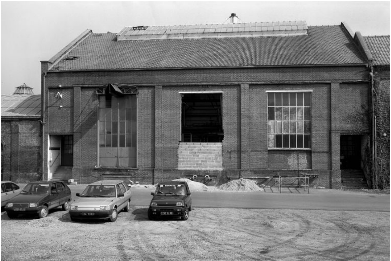
Chaufferie, état en 1988.
