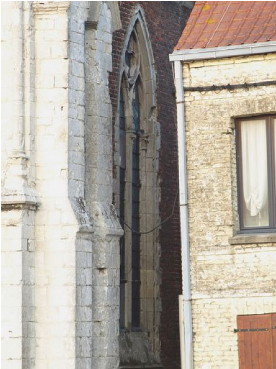
Fenêtre du bas-côté sud : mur en brique et encadrement en pierre calcaire
