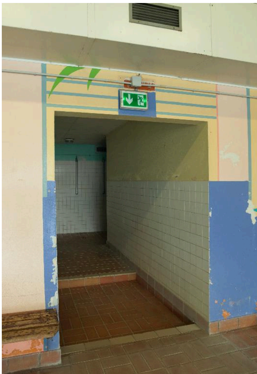
Pédiluve d'accès au bassin.
