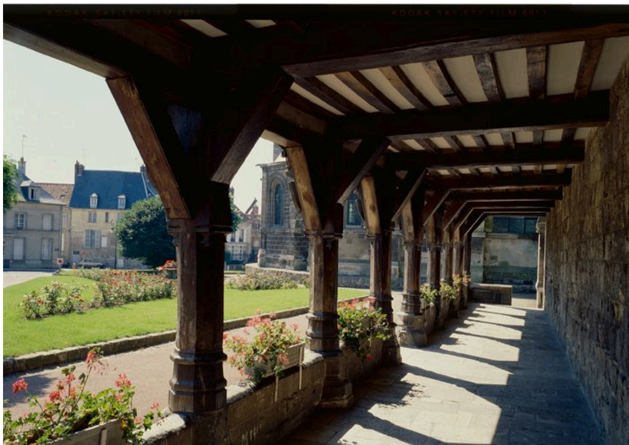
Détail de la galerie.
