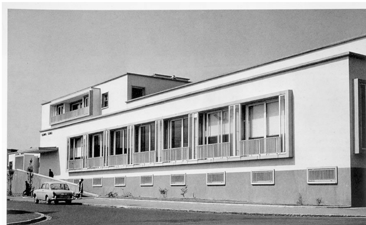
195. Caisse commune de Sécurité sociale et d'allocations familiales à Maubeuge, 1961. Façade est. Le pan de verre enveloppe les poteaux porteurs.
