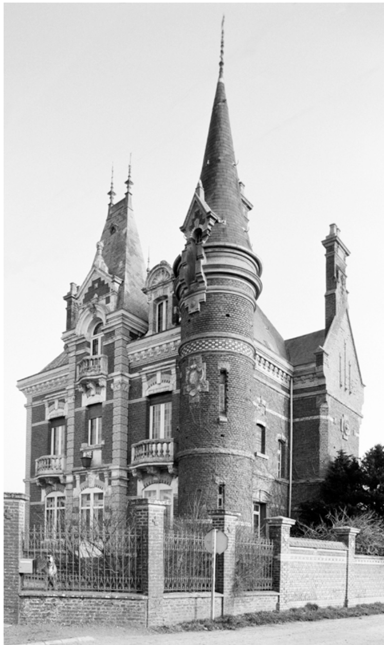
Vue du logement patronal en 1991.
