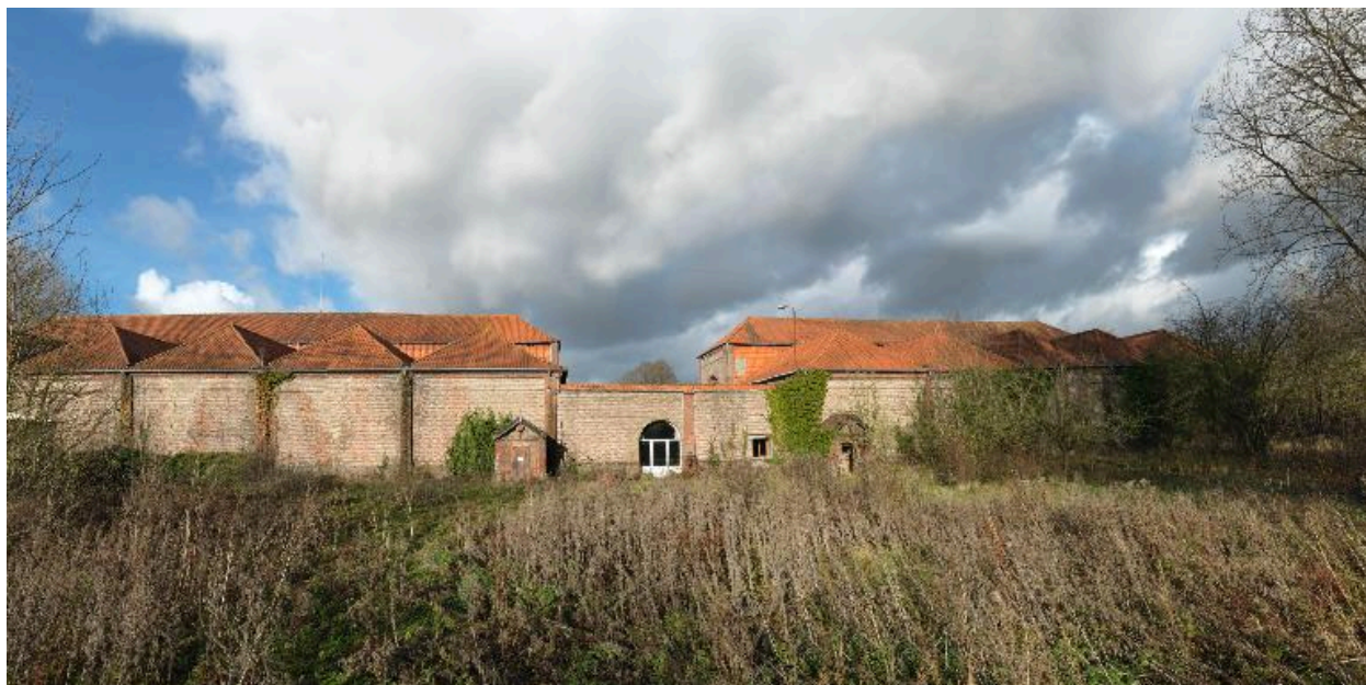
Les seconds entrepôts à jute vus du côté est.
