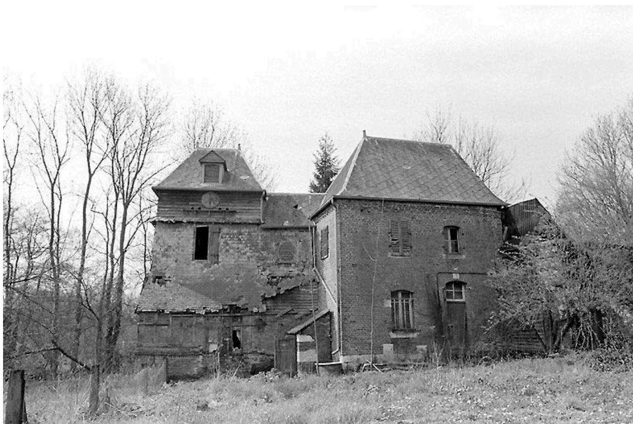
Vue de la tour et du pavillon central.
