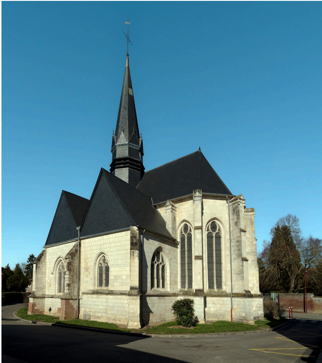
Église, vue prise depuis le sud-est.
