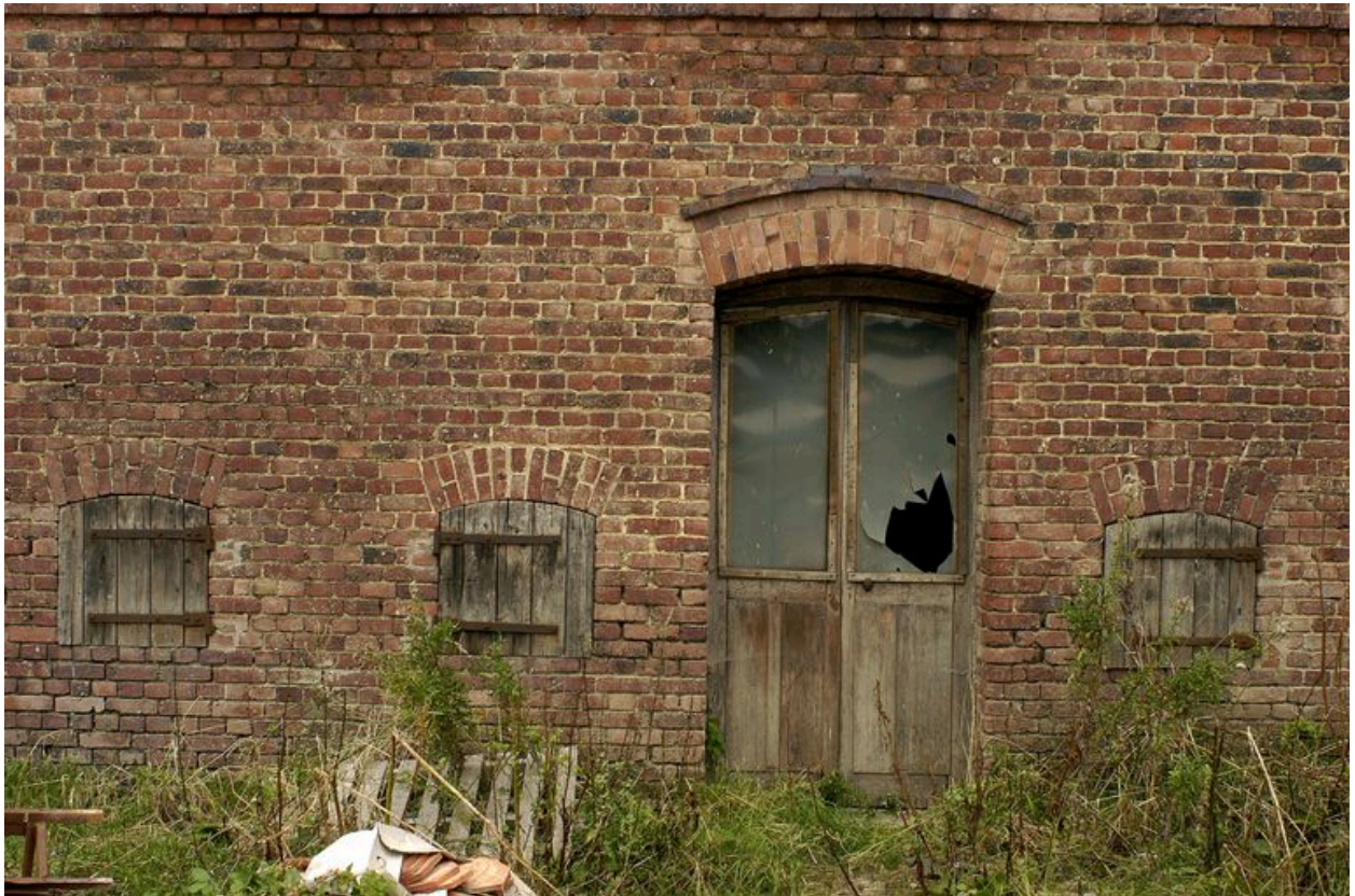
Détail de la façade des anciens magasins à terre.
