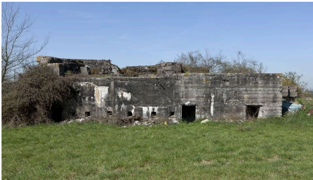
Casemate A : Vers le nord ouest
