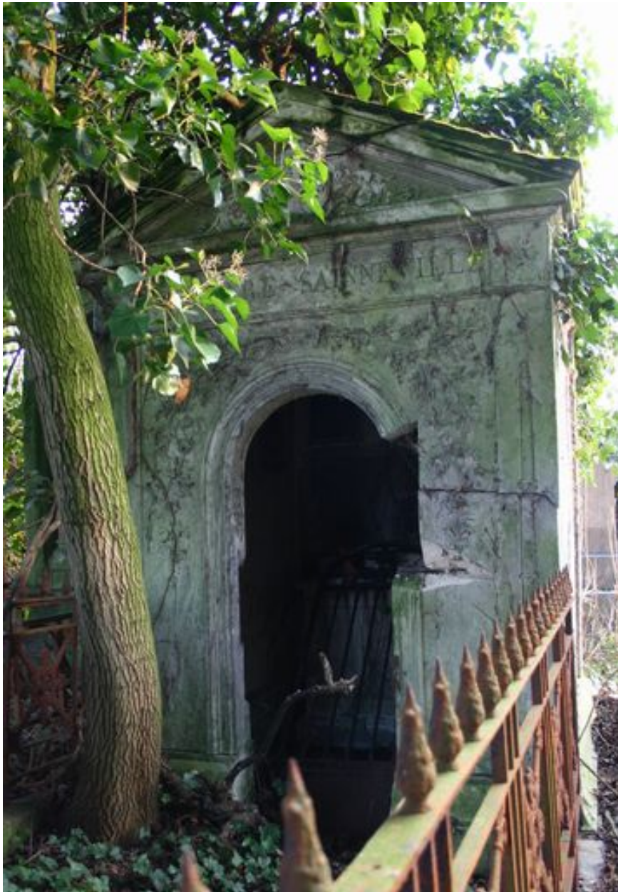
Vue rapprochée de la façade antérieure.
