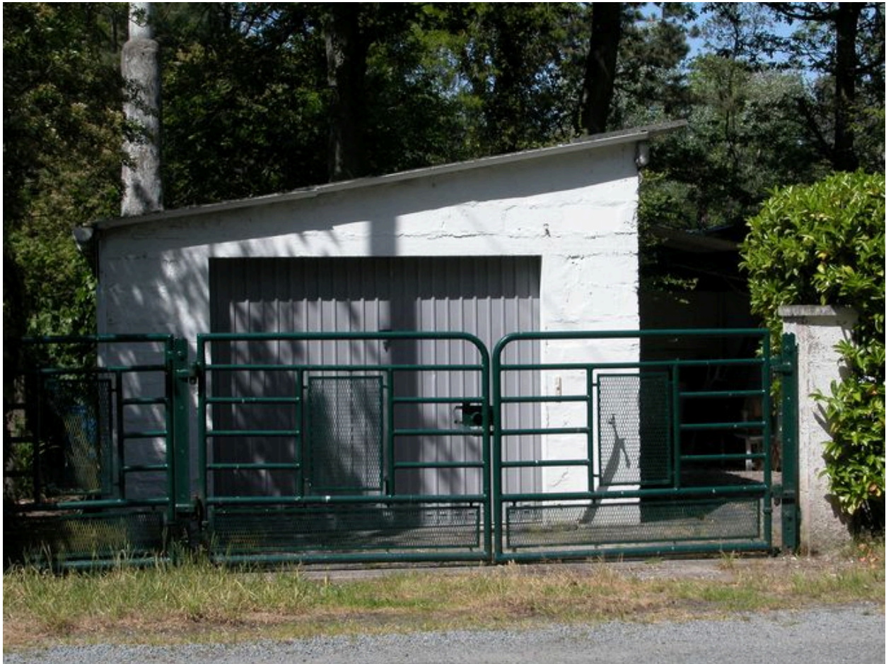
Détail d'un garage isolé et d'une clôture (angle avenues des Chênes et des Peupliers, AD 86).
