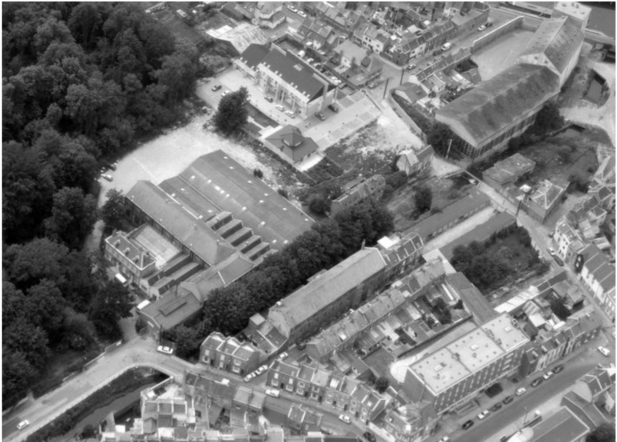
Vue aérienne, flanc nord-est.
