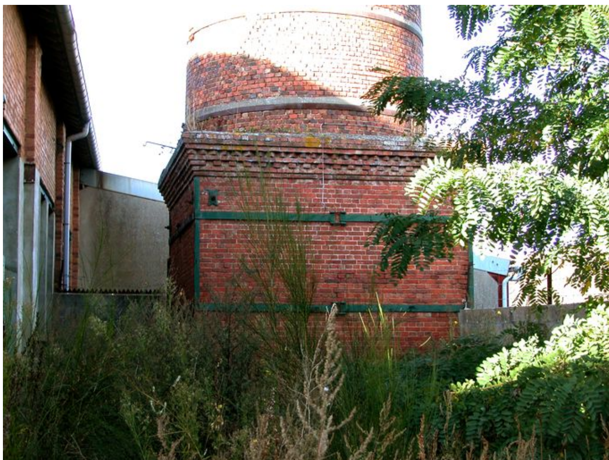
La base de la cheminée.
