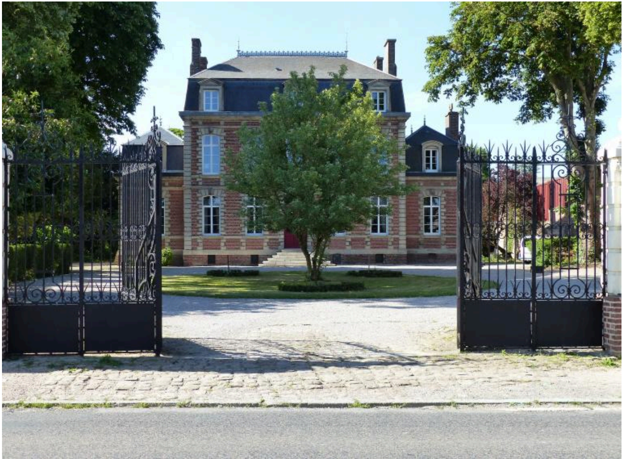
Vue de situation depuis la route.
