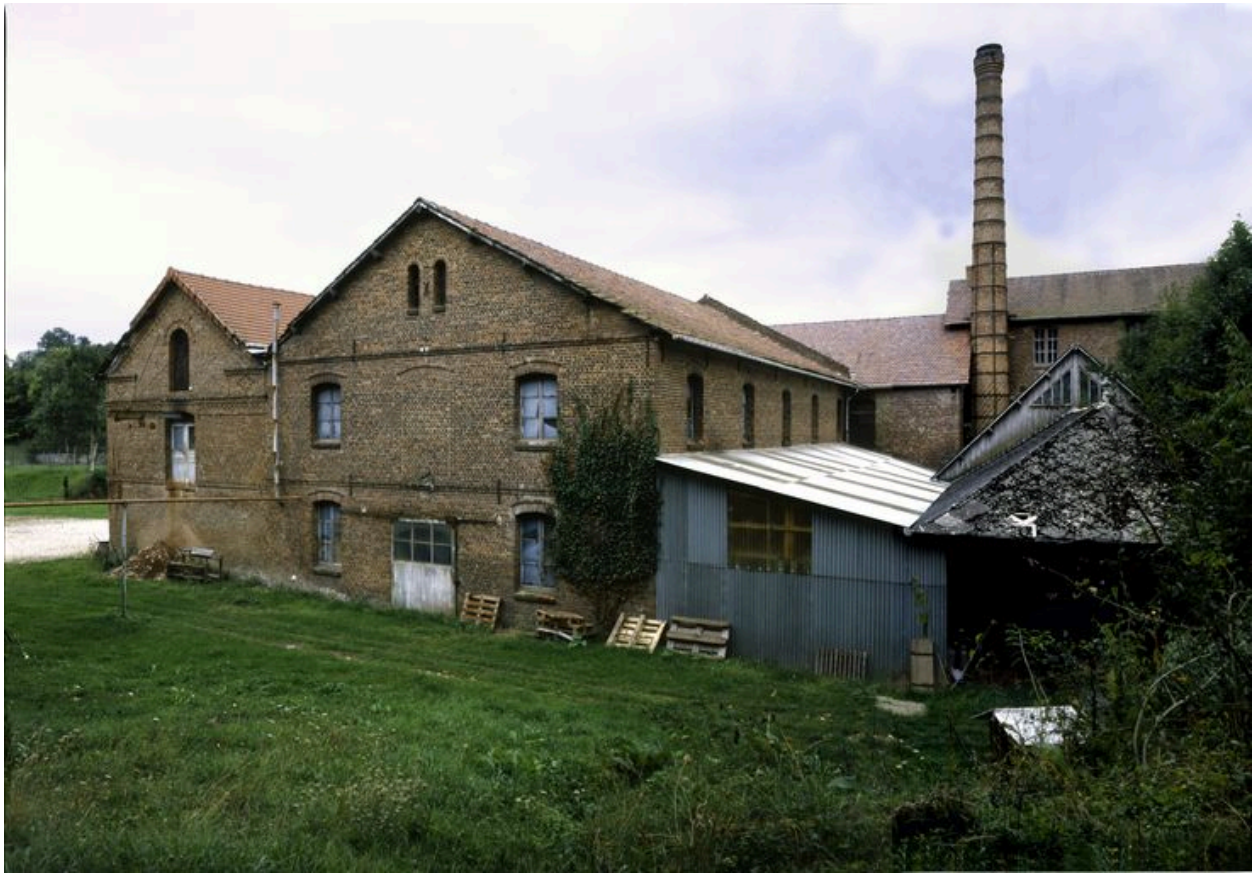
Façade postérieure des ateliers de moulage et d'une des cheminées d'usine.
