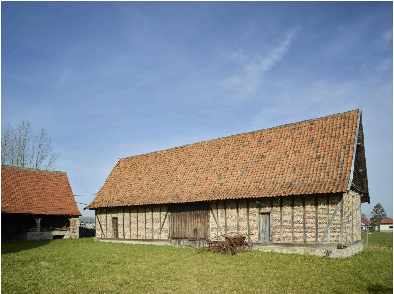
Grange nord. Vue prise depuis la cour intérieure.
