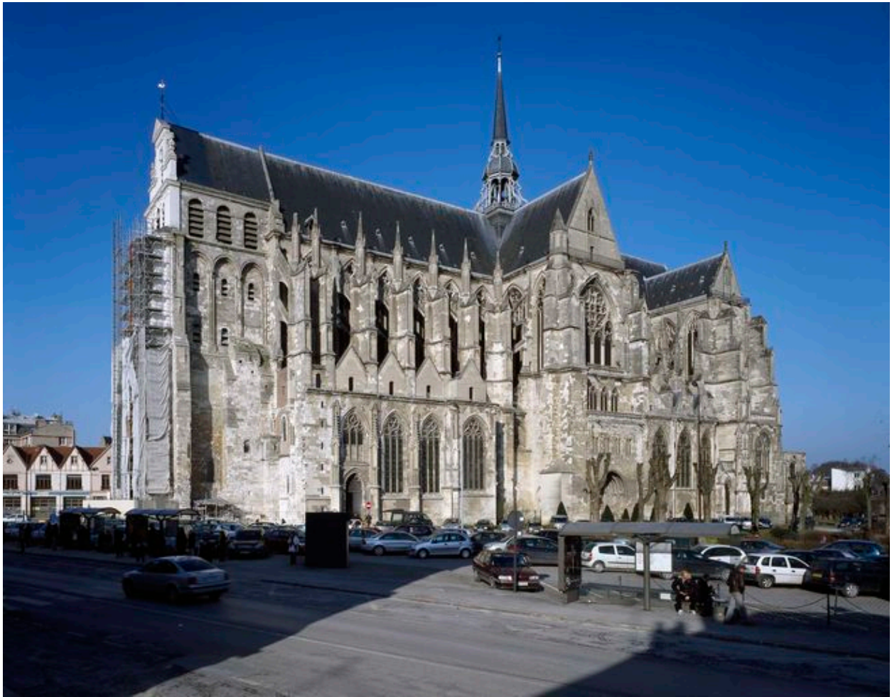
Vue de l'élévation sud.
