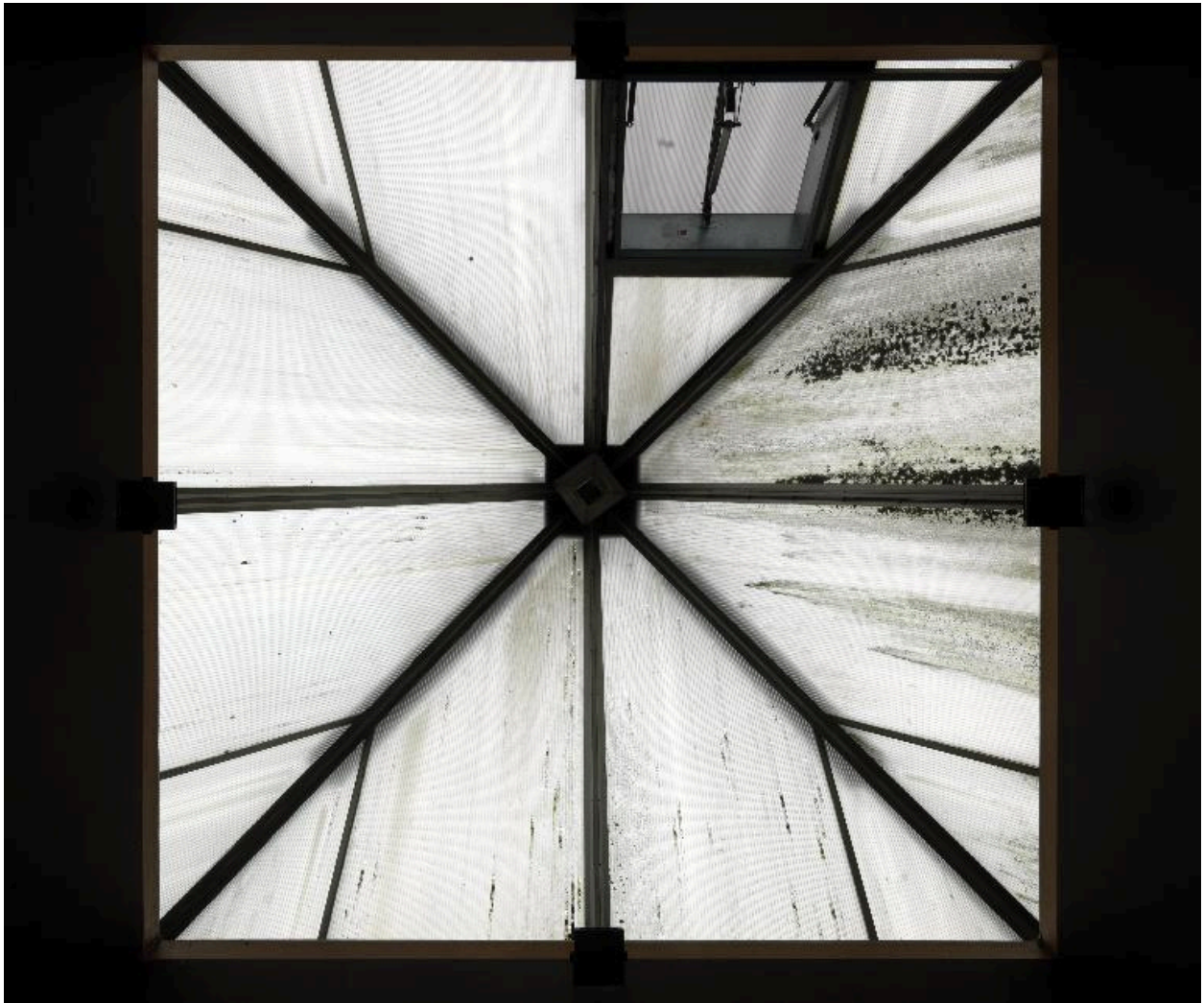
Vue intérieure de l'éclairage zénithal.
