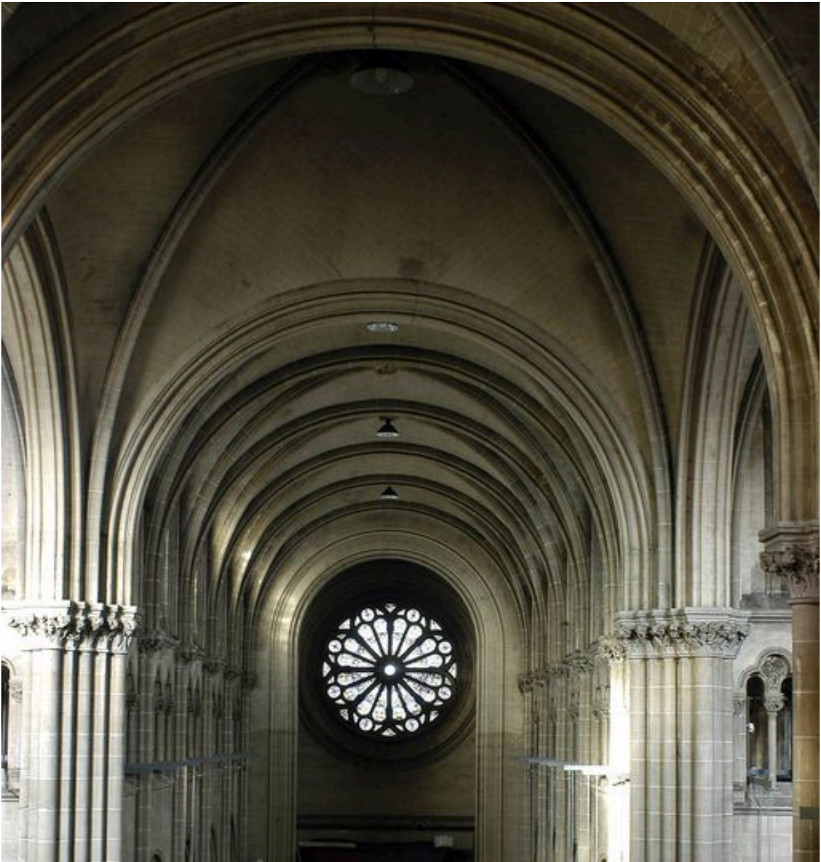
Voûtes de la nef.
