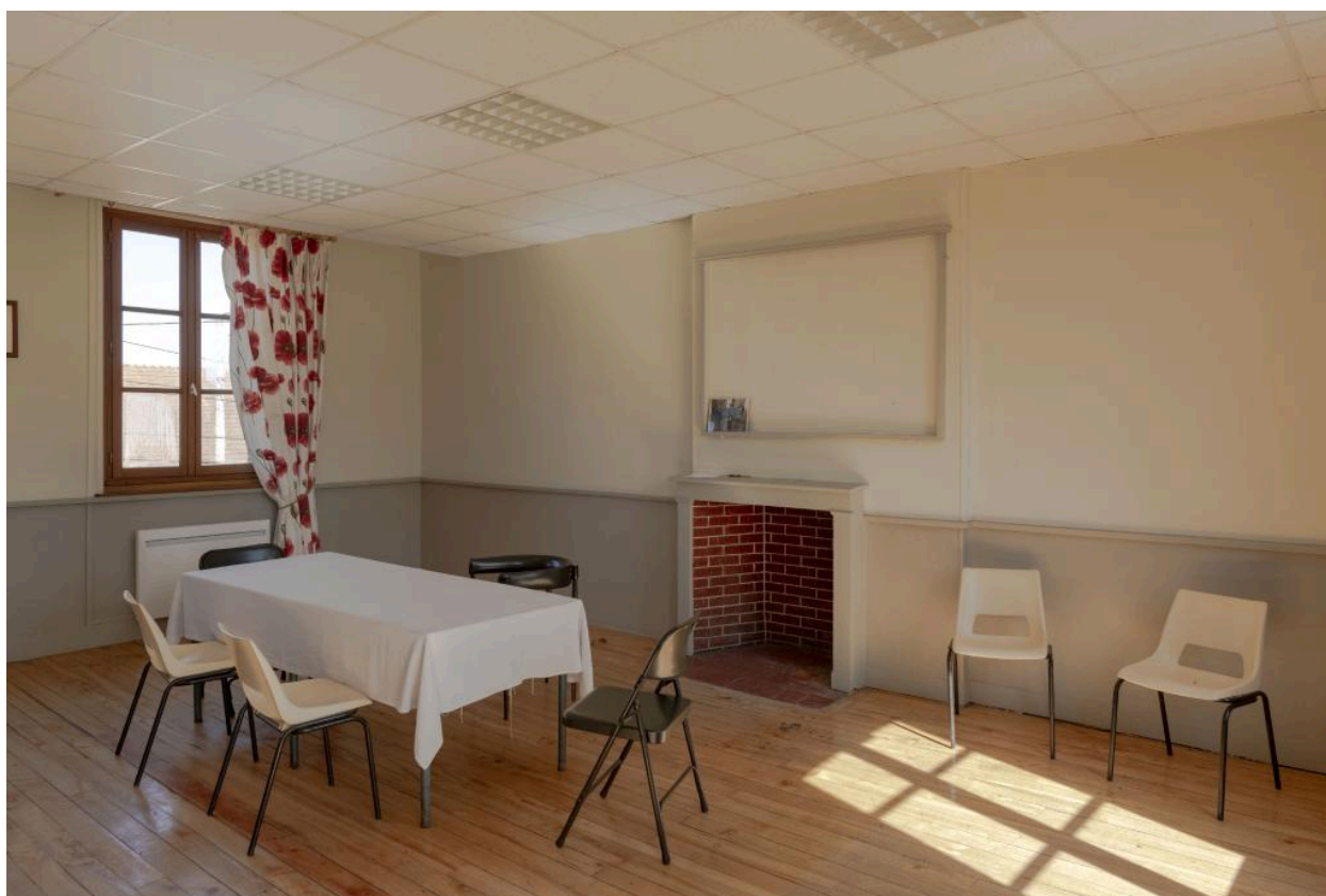
Ancienne salle du conseil municipal, 1er étage de la mairie.
