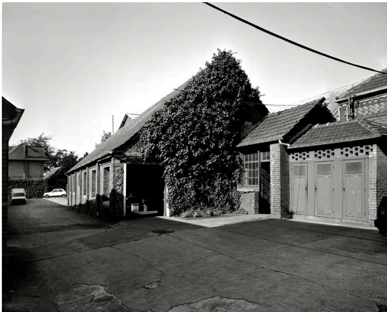
Vue des ateliers, côté cour, en 1988.
