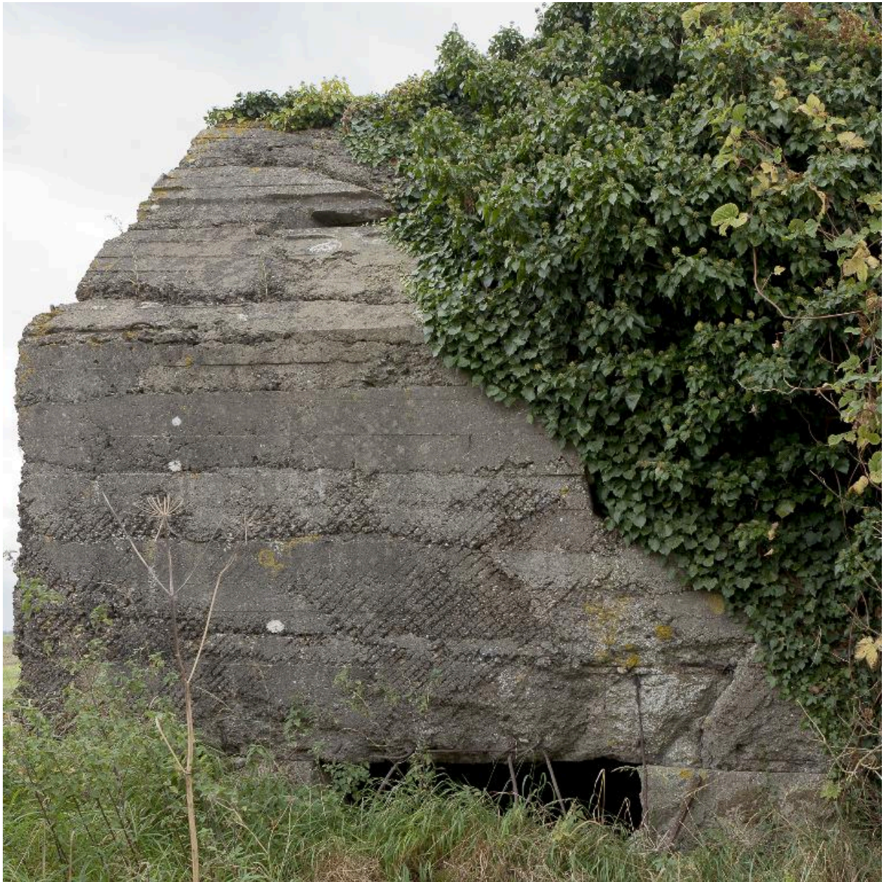
Elévation nord, détail
