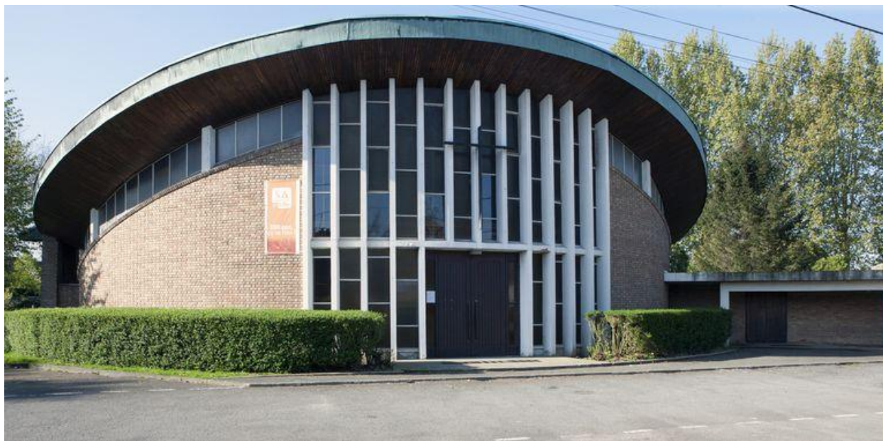
Élévation antérieure de trois quart gauche.
