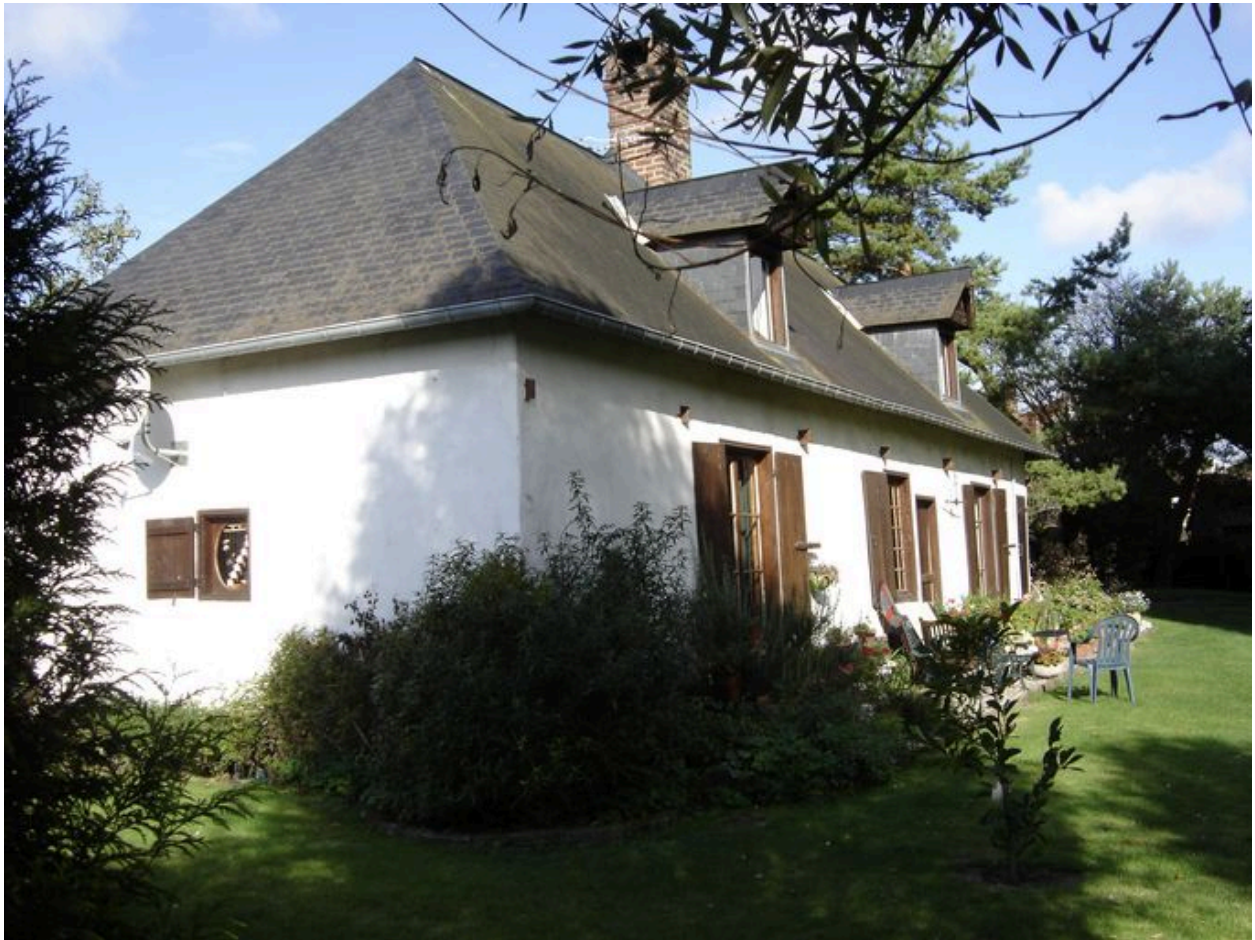
Vue postérieure du logis.
