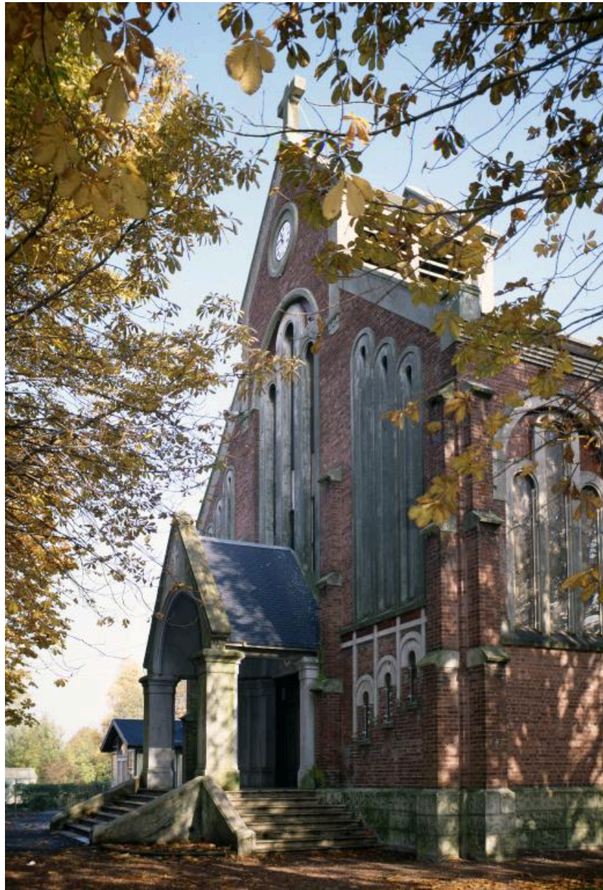
Vue de trois quarts vers le nord-est.
