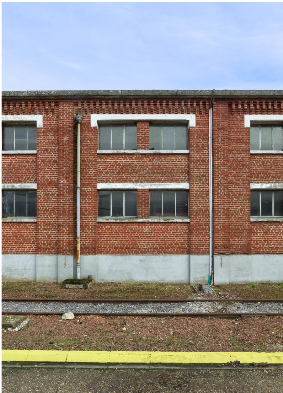
Élévation d'une travée de la façade ouest des entrepôts (bâtiment E).
