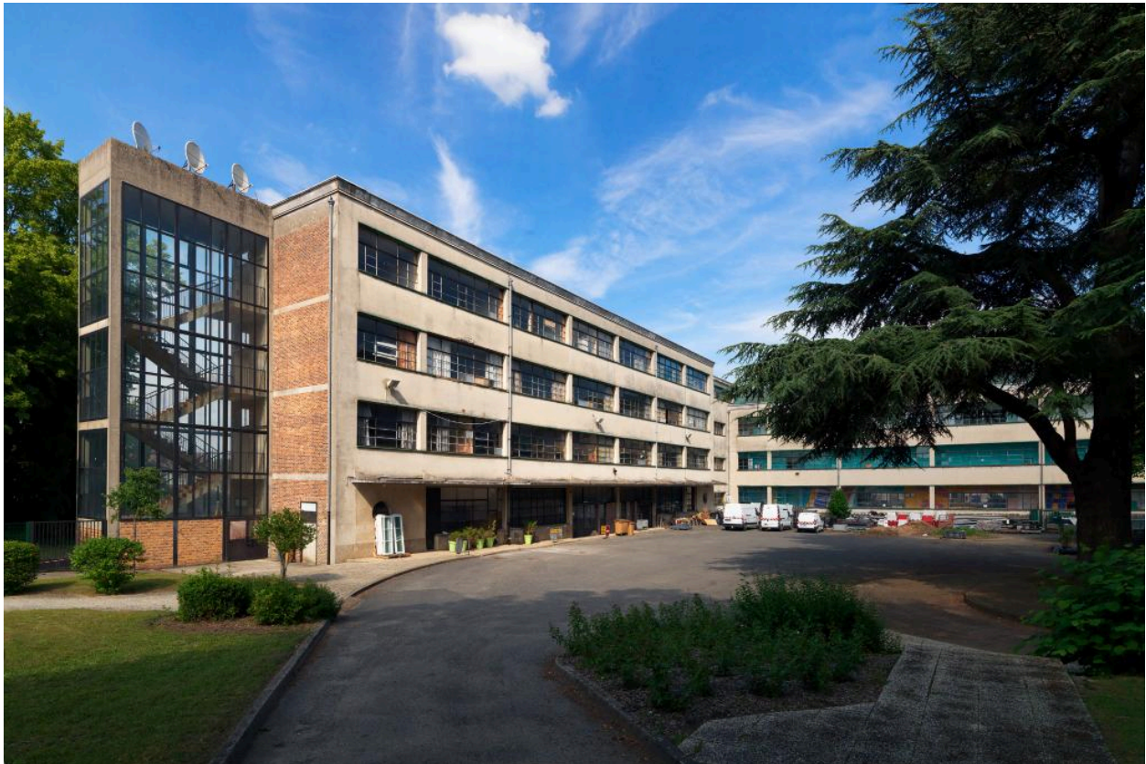
Vue générale du bâtiment en retour au nord, façade sud sur cour.
