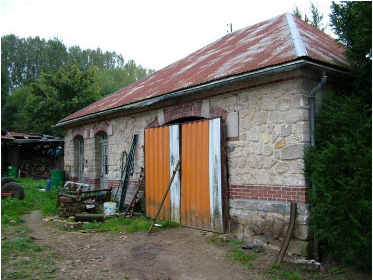
Vue de la remise.
