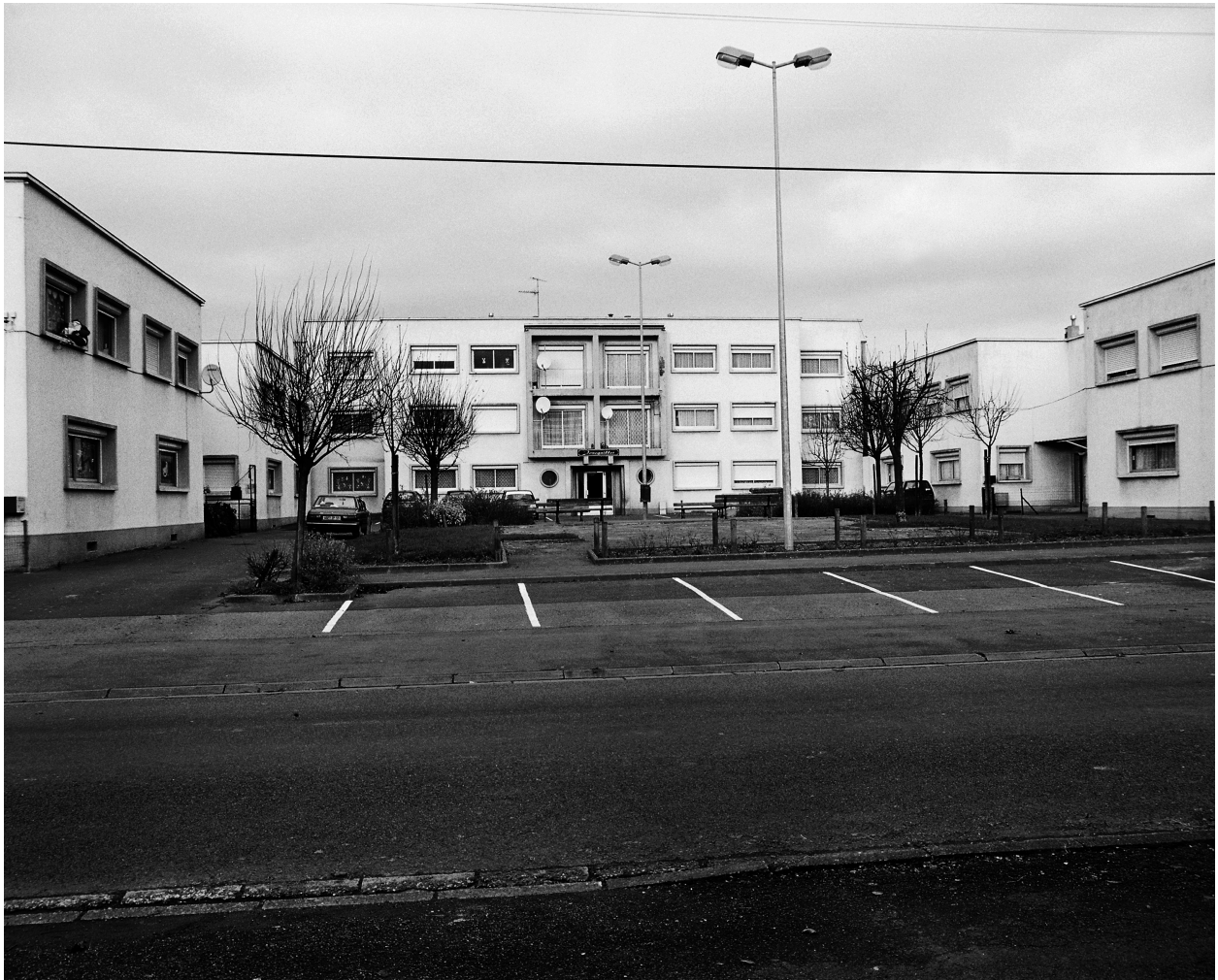
Vue générale d'une place : pavillons (à gauche et à droite) et immeuble collectif (dans le fond).
