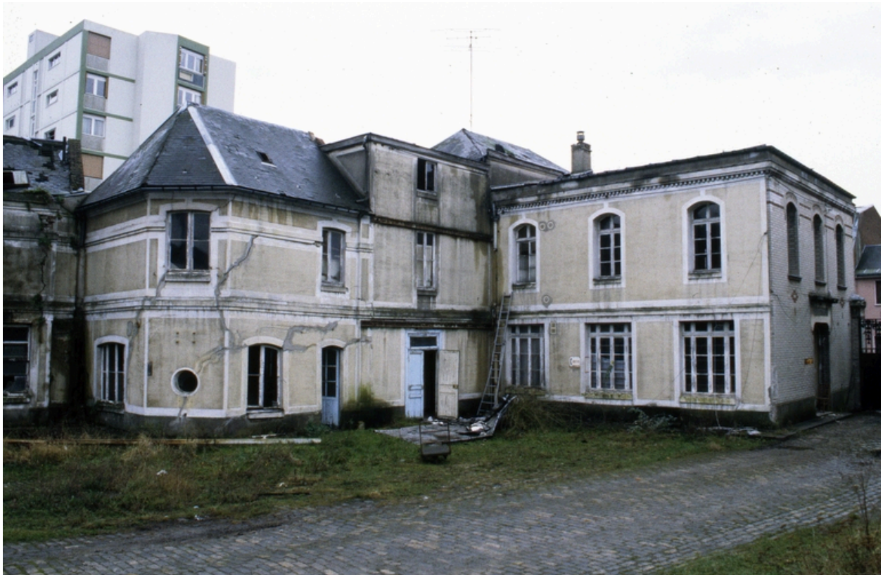
La conciergerie et les bureaux de l'usine, façade sur cour, 2001.
