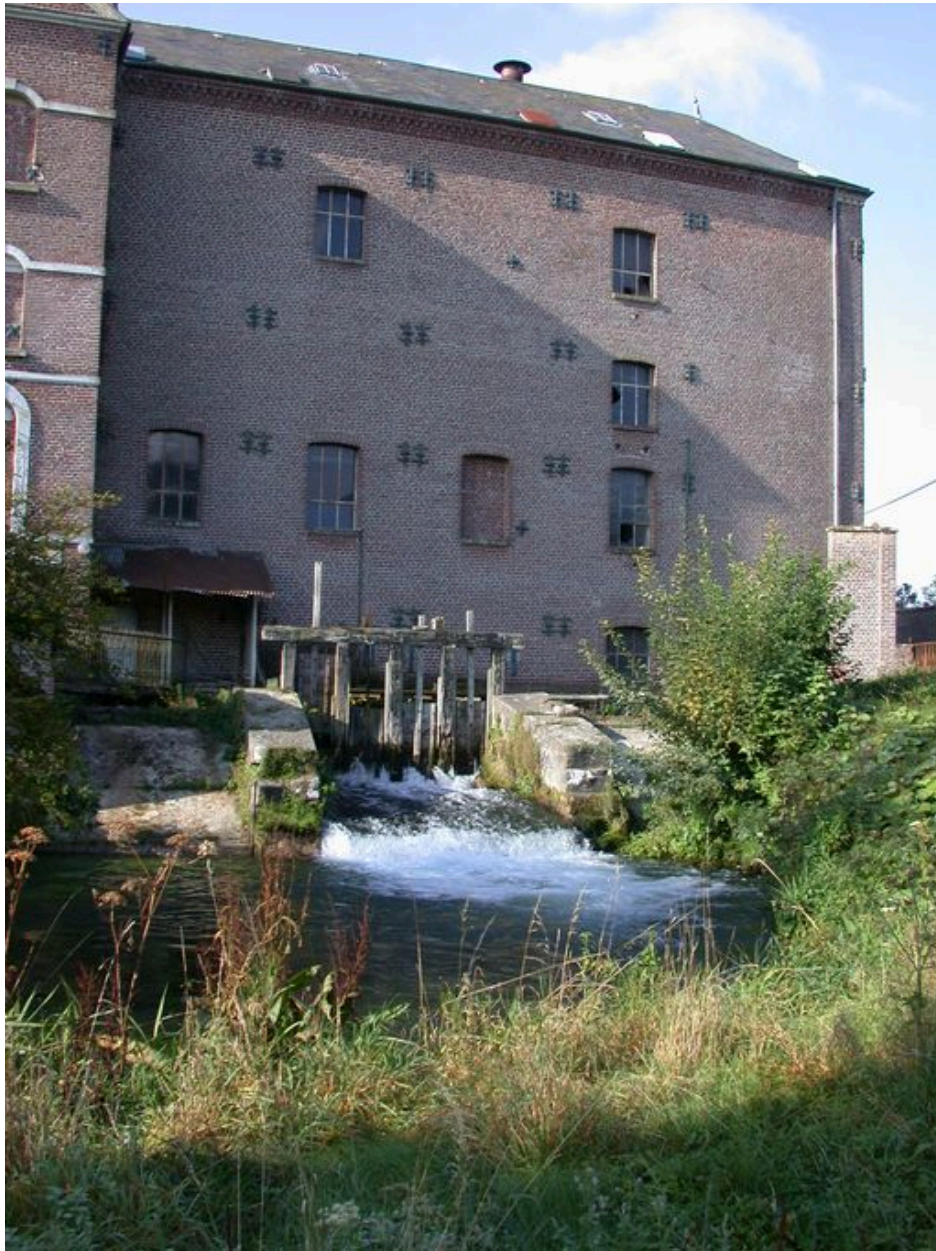
Elévation postérieure de la minoterie, les vannes de décharge et le déversoir.
