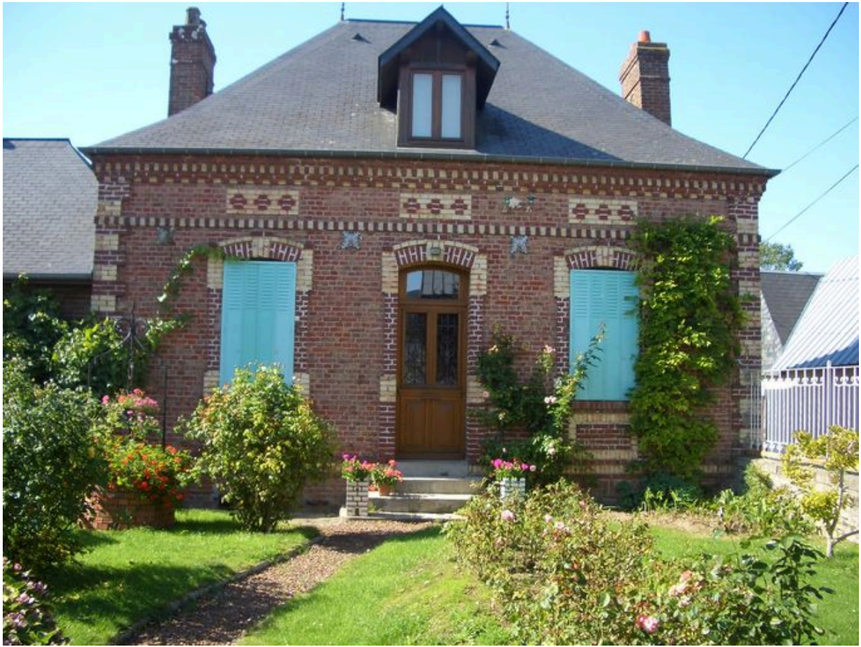
Vue du logis principal.
