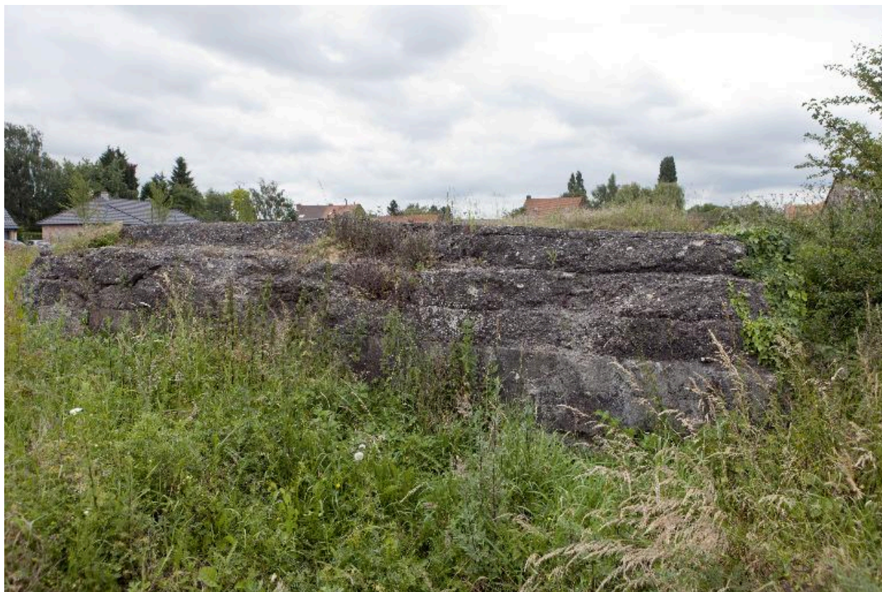
Casemate à personnel (Bat. B)
