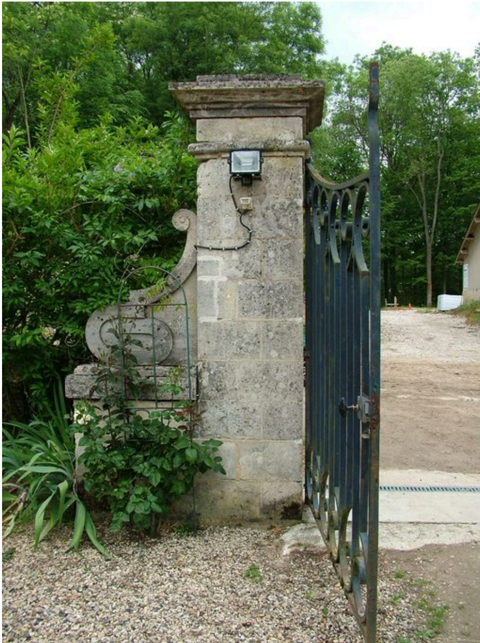
Pilastre du portail d'entrée.
