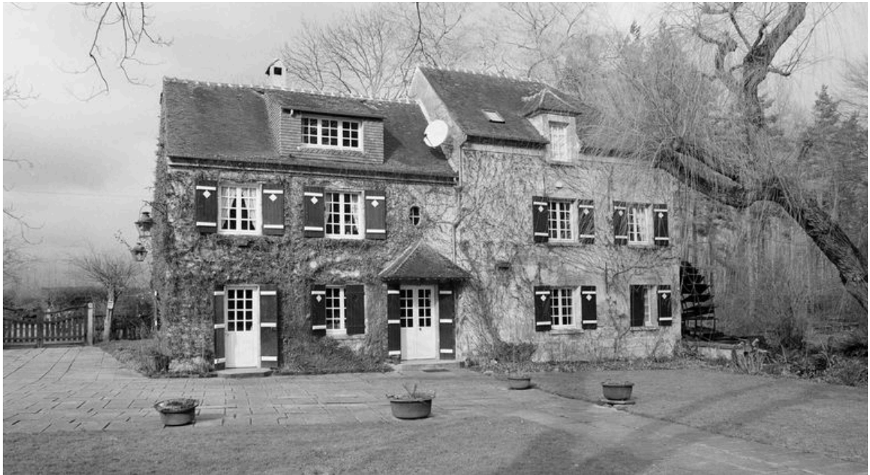
Vue générale du moulin : façade postérieure.
