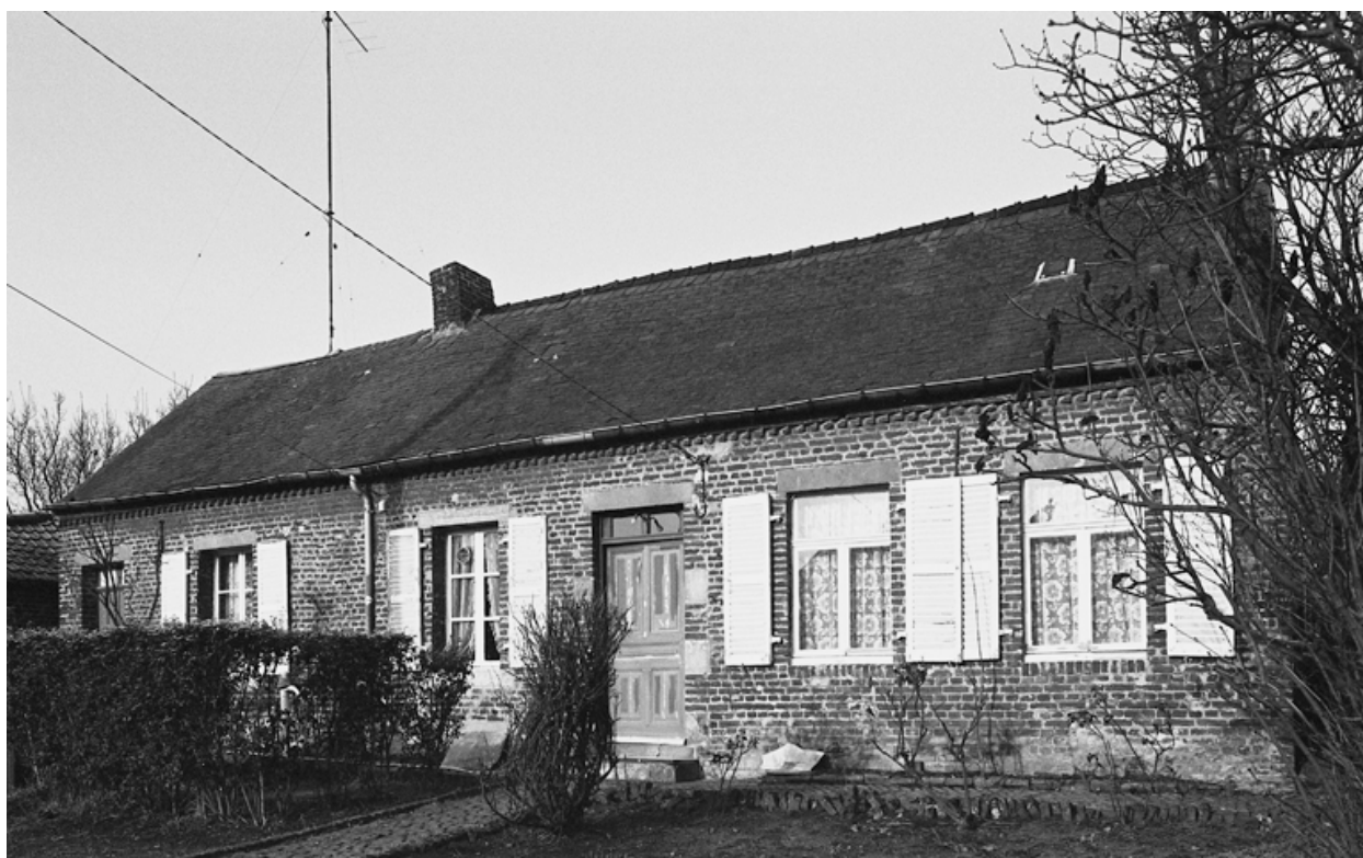
Vue d'ensemble de la façade.
