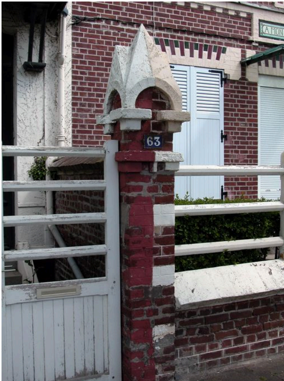
Détail d'un pilier du mur de clôture.
