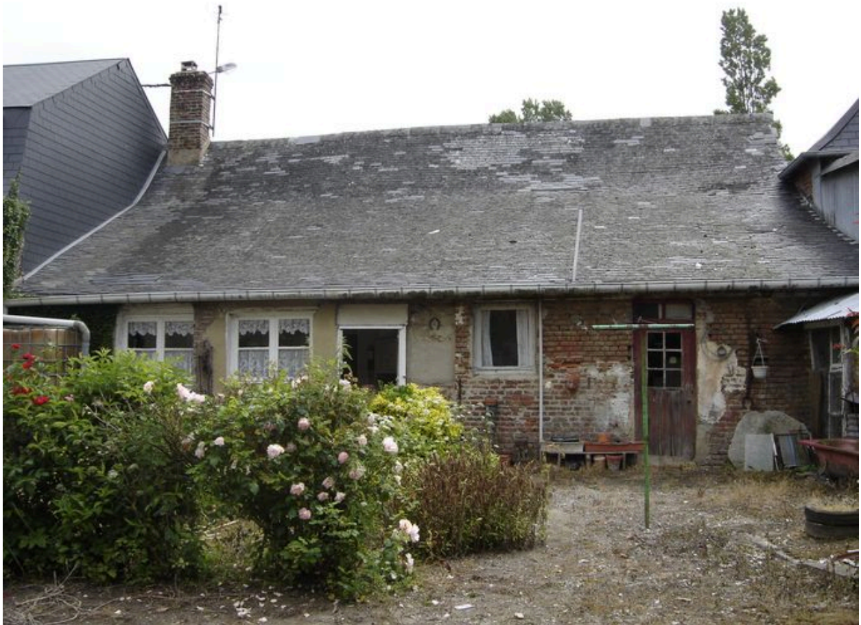
Vue postérieure depuis la cour intérieure.
