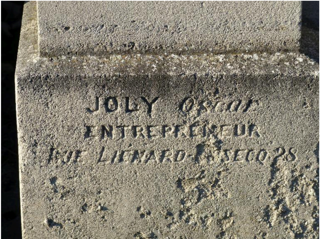
Vue de détail sur la signature de l'entrepreneur.
