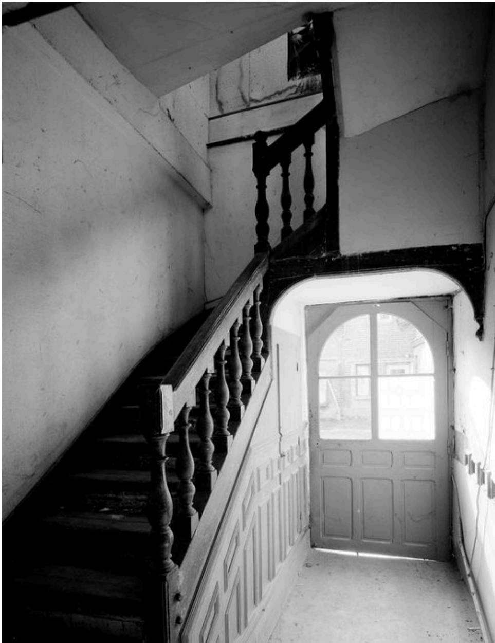
Vue intérieure : départ de l'escalier.
