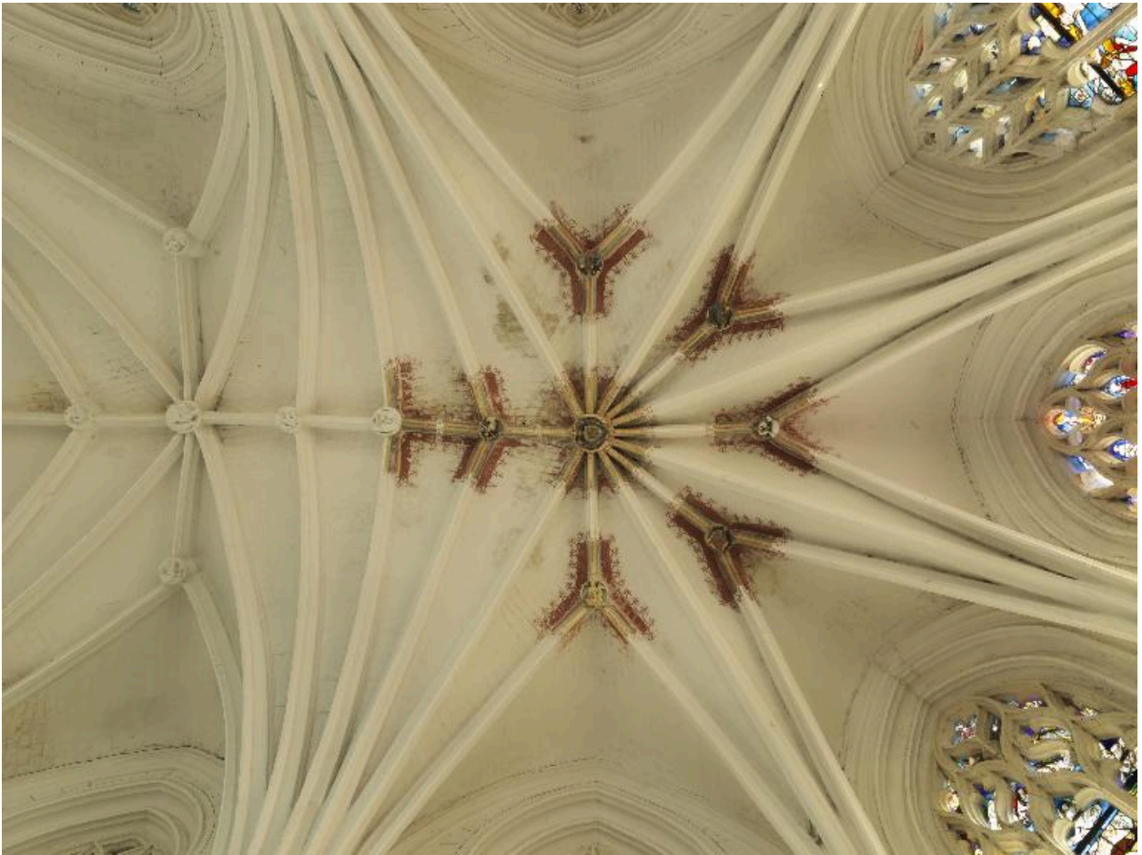
Voûte d'ogives et à nervures multiples du chœur.
