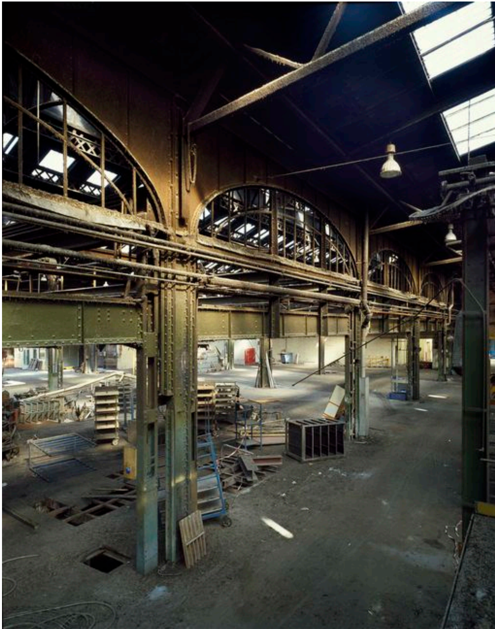
Structure Eiffel : détail d'une travée.
