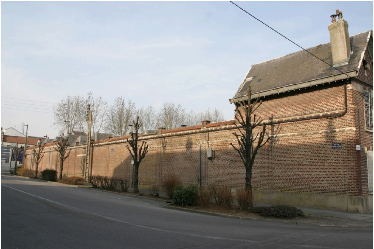
L'usine vue depuis la rue de Tour-Y-Val.
