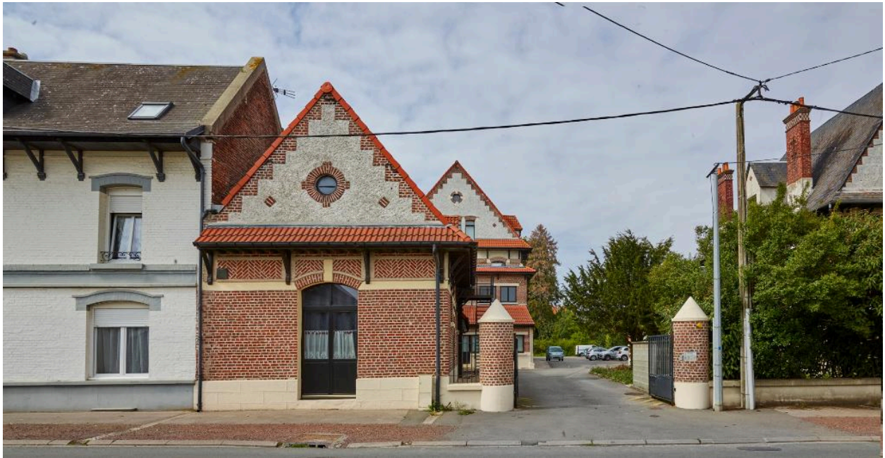
Façade de l'ancienne écurie depuis la rue du Maréchal Leclerc.
