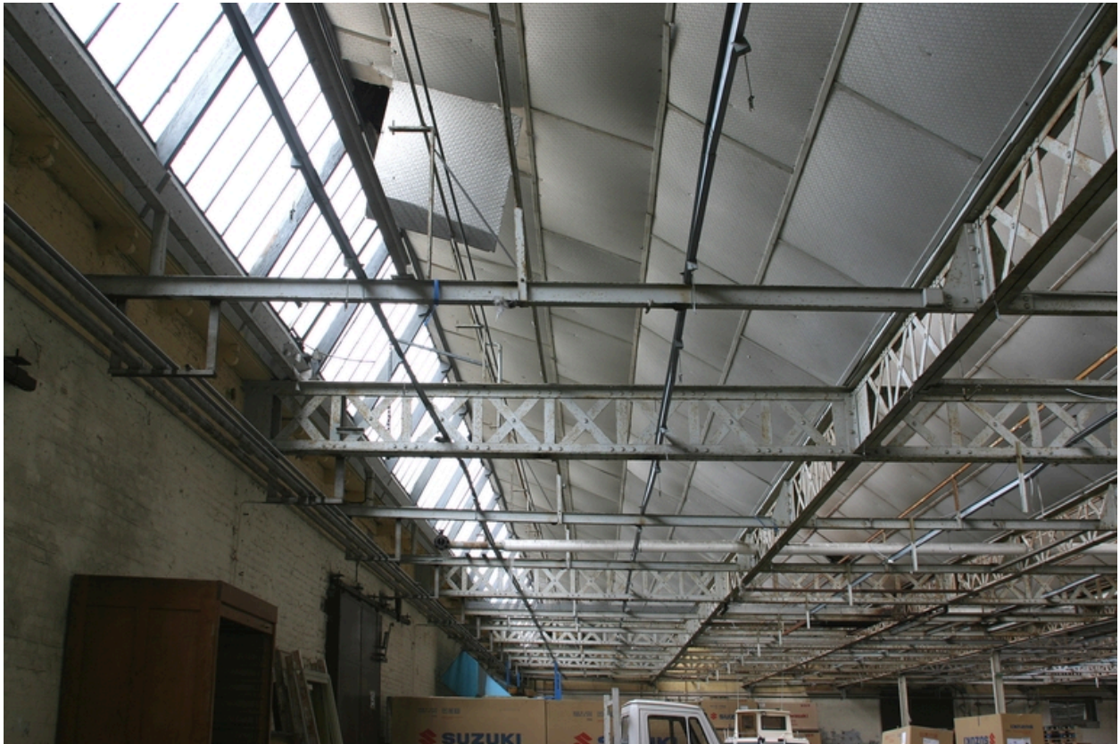
Ateliers de 1921 : détail d'un shed.
