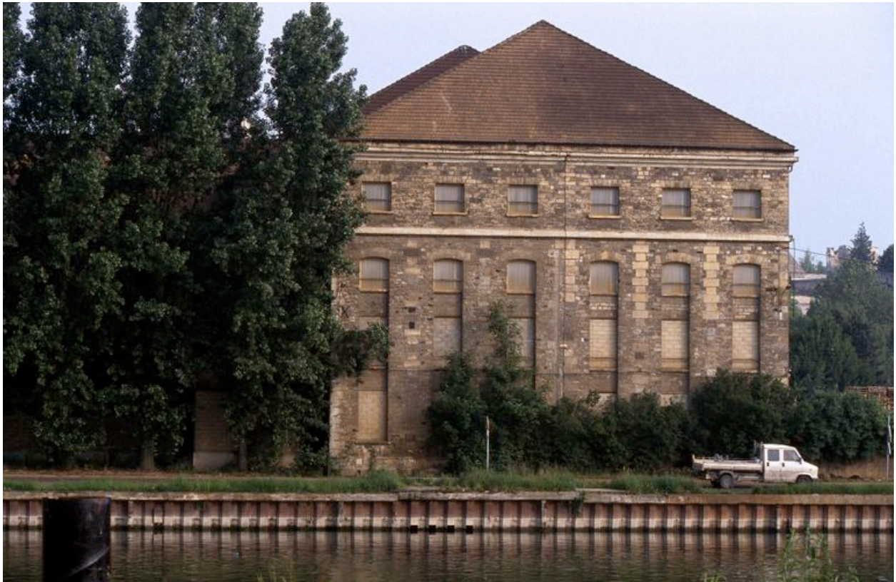
Façade de l'atelier de fabrication.
